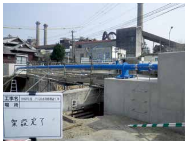
老朽化した管路の更新による耐震化②
