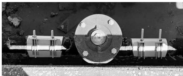
橋梁添架部の漏水補修管路
