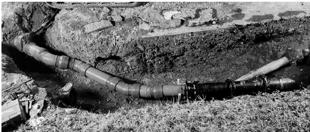
配水用ポリエチレン管（HPPE）及びダクタイル铸铁管（K形）配管状況
