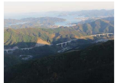
▲尺間山から見た東九州自動車道
