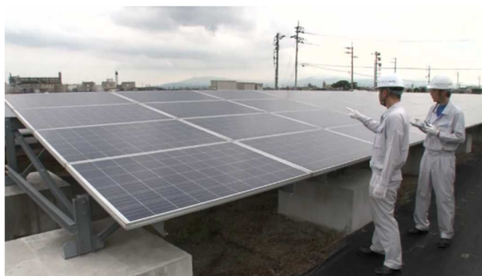
図表 55 太陽電池モジュールの外観検査
