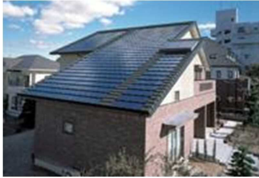
図表 11 屋根置き型太陽光発電システム例
