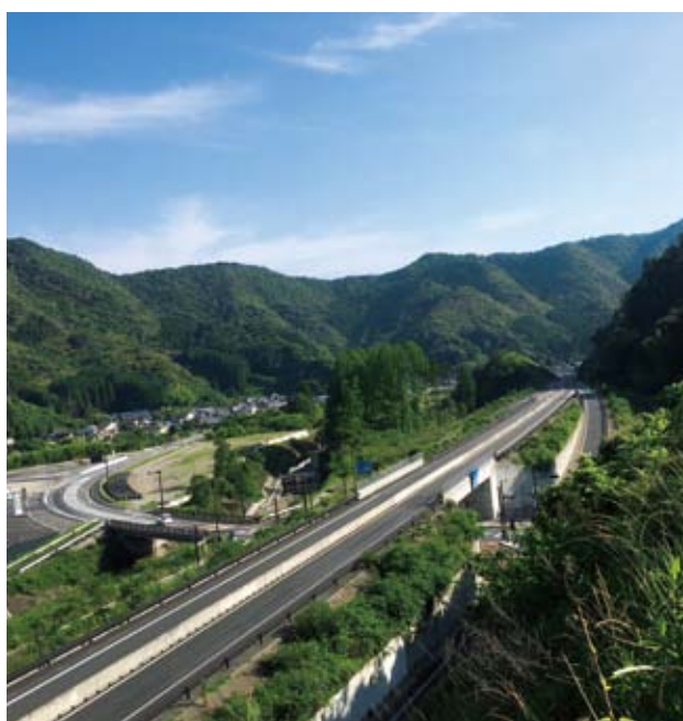
暫定2車線の東九州自動車道
