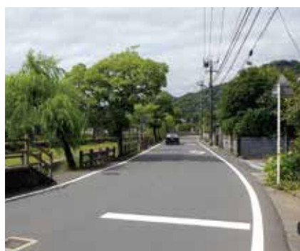
道路整備状況
